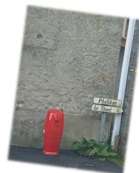
Philibin Poteau incendie n° 9
