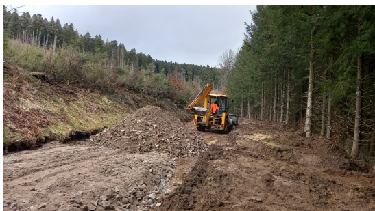
Rechargement avec apport de matière
